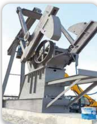
Pompage du Brut Maretap Zarzis
